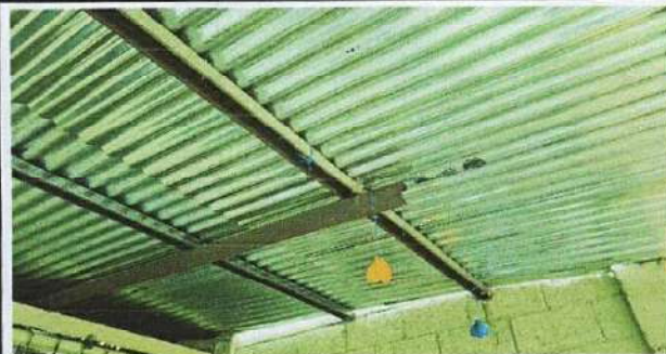
FOTO 6: Mantenimiento a estructura de techo portante galvanizada con tubo de 4x4 y porta lámina de 2x3
