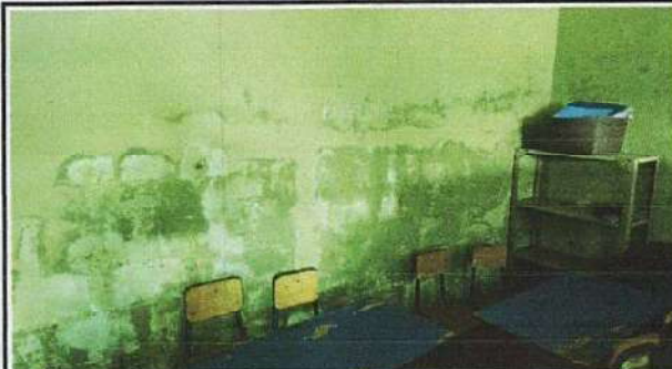
FOTO 4: Reparación de repello y cernido en paredes interiores y exteriores aplicación impermeabilizante de zika salitre, en aula de párvulos
