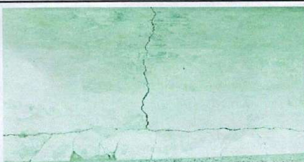
FOTO 5: Reparación de losa de piso de concreto fisurada en aula de párvulos
